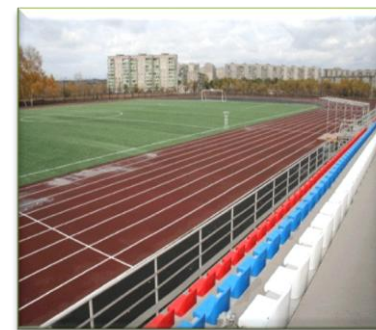
Реконструкция футбольного поля и беговых дорожек стадиона «Северный»
