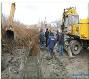
Строительство тепломагистральной, в т.ч в пос.Строитель
