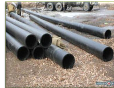
Строительство водовода от пл.Гагарина до Трикотажной фабрики
